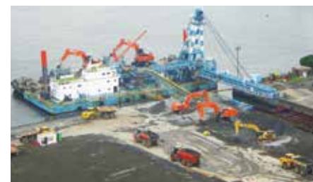
落下混合工法
