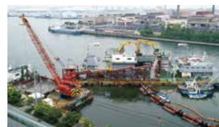
管中混合工法
