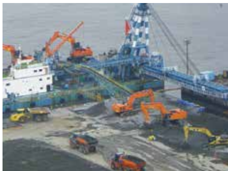
落下混合工法
