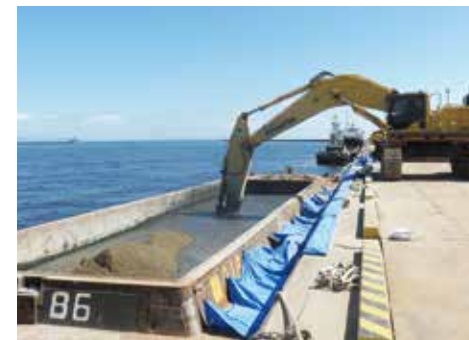
バックホウ混合工法
